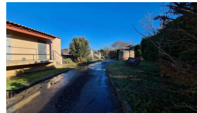
Image 15 : Station d'épuration ; SOLiHA Méditerranée, 2021
