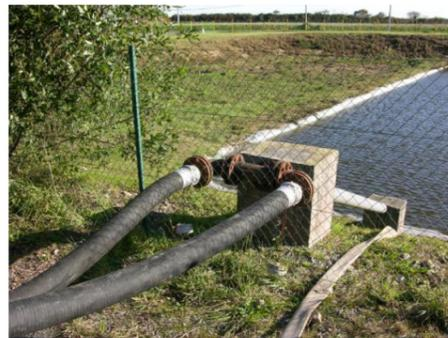
Réserve d'eau ouverte avec 1 colonne de 150 mm alimentant 2 sorties de 100 mm
