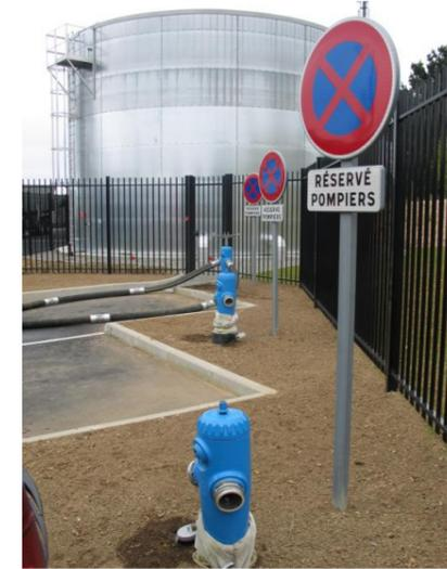
Réserve d'eau incendie aérienne de 720 m<sup>3</sup> équipée de 3 poteaux d'aspiration de 150 mm
