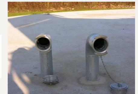
Deux colonnes d'aspiration de 100 mm sur une réserve d'eau enterrée
