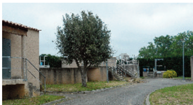
Station d'épuration de Villegly
